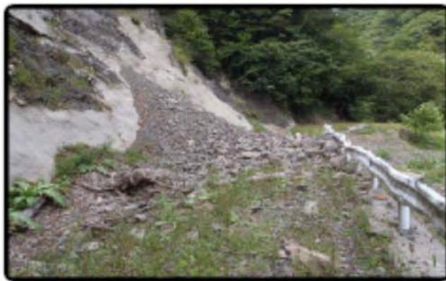
砂防堰堤管理用道路の土砂等除去作業
