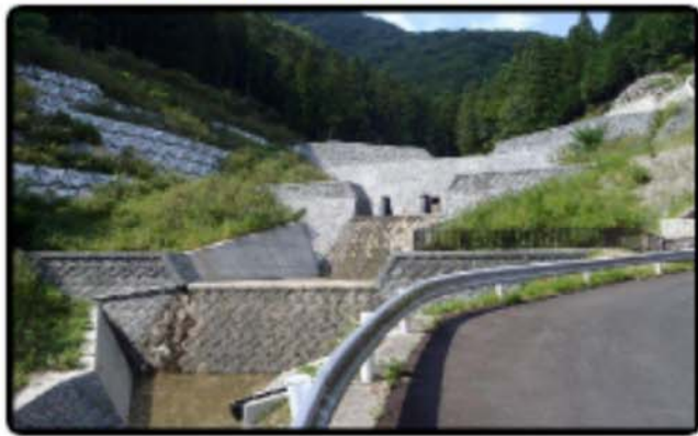
砂防堰堤周辺における除草作業
