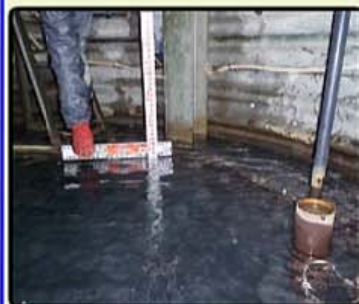
集水井内部土砂除去前
