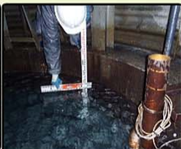
内部堆積土砂除去後
