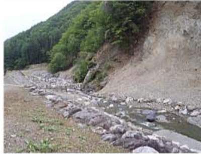
崩落土砂撤去完了
