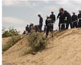
竹流しと呼ばれる水防工法
