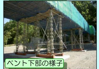
橋全体で約225tある重量を、8箇所を設置した「バント+ジャッキ」を使って持ち上げます（ジャッキアップ）。
