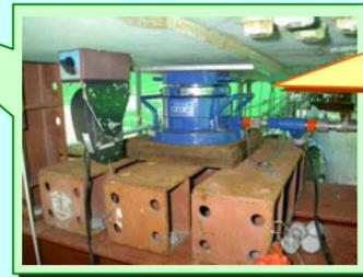
その後、主桁架け替え→主桁補強→ジャッキダウン→補強材架設→床版・塗装を行って完成です。
