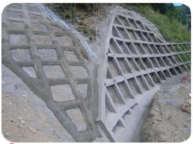
③ 吹付法枠工・簡易吹付法枠工
