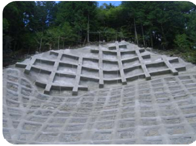
① 吹付法枠工・簡易吹付法枠工
