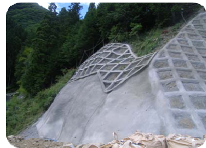
② 吹付法枠工・モルタル吹付工
