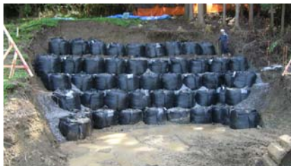
協議の結果、耐久性の良い耐水性土のうを設置することにしました。合計 50個作成・設置しました。
