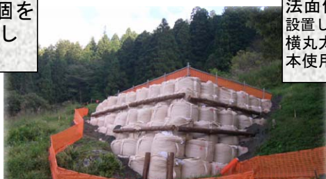
クレーンヤード 設置完了
