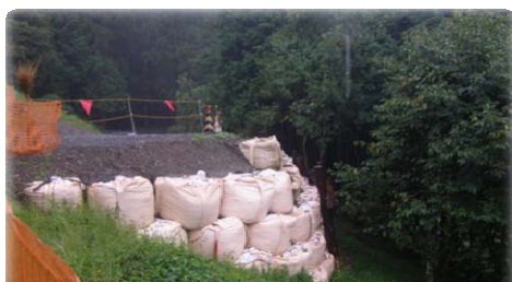
工事用道路出入口 完了時
