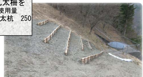
クレーンヤード 撤去完了
