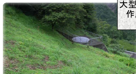
クレーンヤード 着手前 (WA-7集水井)
