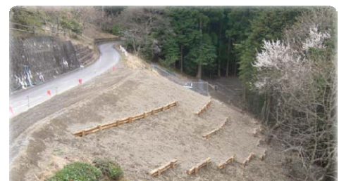
工事用道路出入口 撤去完了
