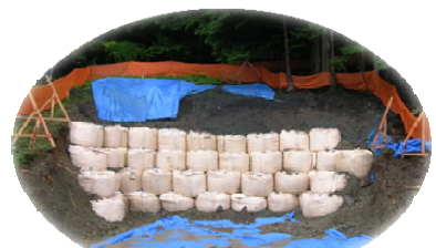
9月の上旬湧水と降雨より仮設土のうを設置しましたが崩壊しました。
