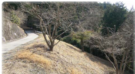
工事用道路出入口 着手前
