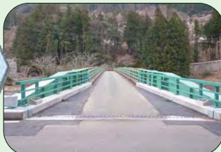
補強工事完了箇所
