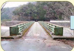
今回工事箇所
