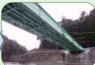
桁補強 桁増設
