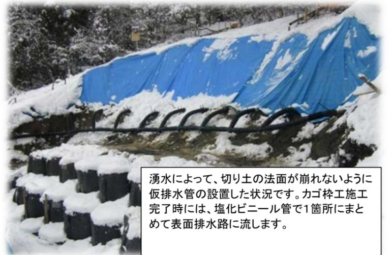
湧水によって、切り土の法面が崩れないように仮排水管の設置した状況です。カゴ枠工施工完了時には、塩化ビニール管で1箇所にまとめて表面排水路に流します。
