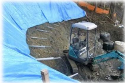
右の写真は、湧水をパイプでつなぎ1箇所に集めるために施工された状況です。下の写真は、処理完了後の出水状況です。通常、10本で毎分約80リットルくらい出ていますが降雨がある場合は、約2倍から3倍になります。
