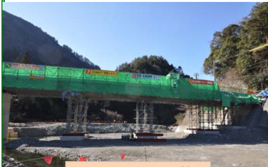
仮設ベント 4基
