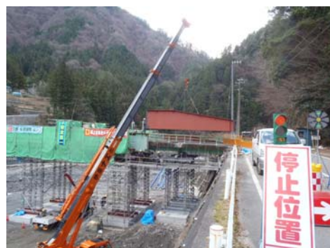
新設主桁設置
