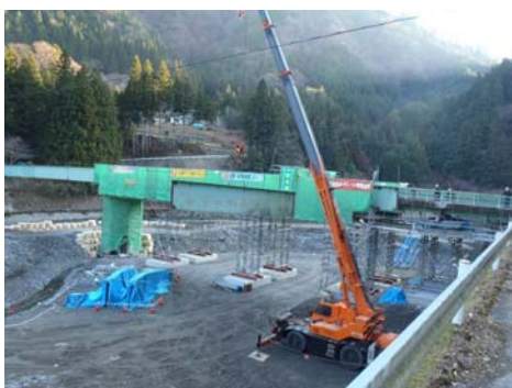
既設主桁撤去
