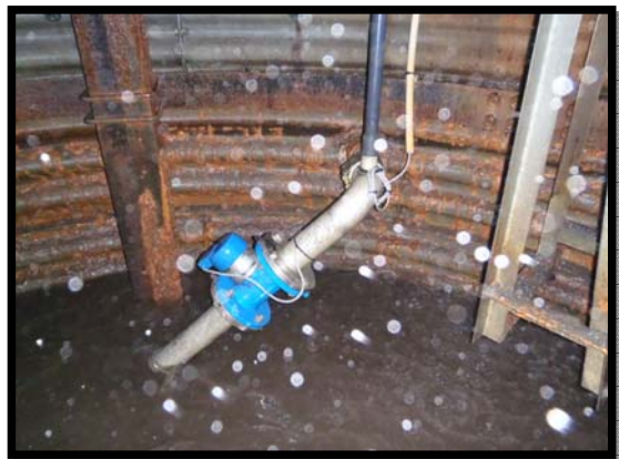
清掃前(此田地区、集水井内部)
