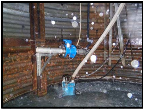
清掃後(此田地区、集水井内部)
