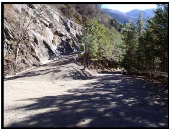
完成 (柳沢砂防堰堤管理用道路)
