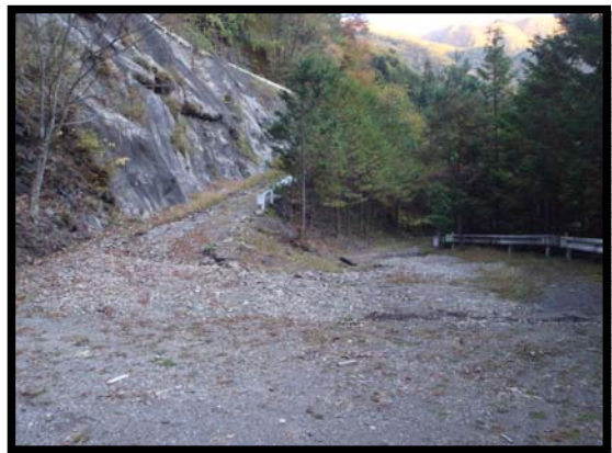
着手前 (柳沢砂防堰堤管理用道路)
