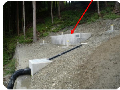
このパイプを通じて下の集水樹へ地下水を排出します
