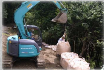
工所用道路 大型土のう設置状況
