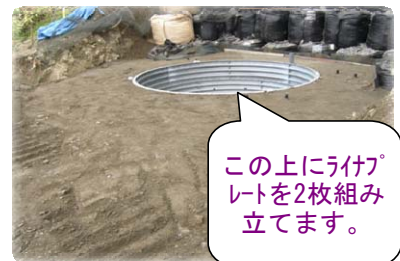
WA-28 集水井 根巻きコンクリート施工完了
