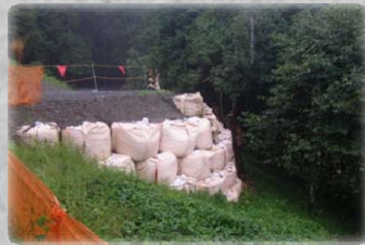
工所用道路 完成
