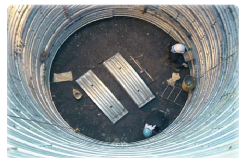
ライナプレート組立状況
