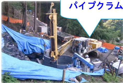
集水井掘削状況
