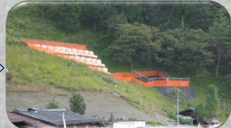
WA-7集水井 クレーンヤード完成
