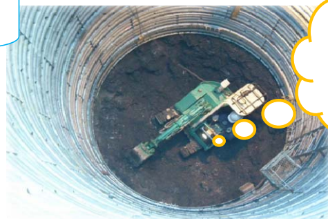
集水井内 掘削状況
