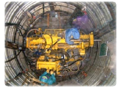
削孔作業状況
