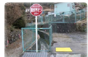
防火水槽の表示板と蓋の新設をしました。
