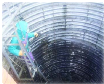
集水井内清掃状況
