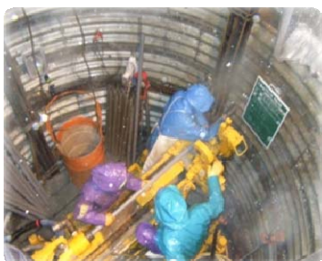
保孔管挿入状況
