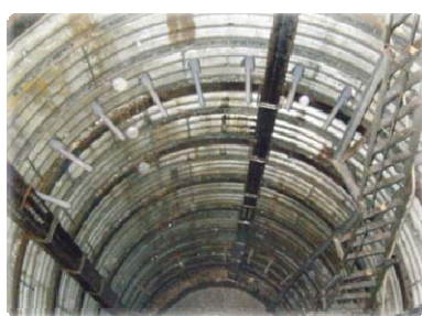
集水ボーリング施工完了
