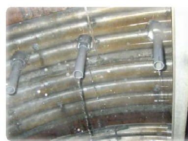
集水ボーリング出水状況
