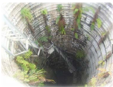
施工前の集水井内
