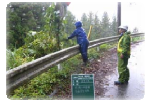
工事着手前にカーブミラーの清掃を行いました。
