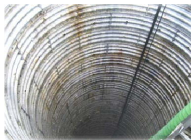
集水井内清掃完了
