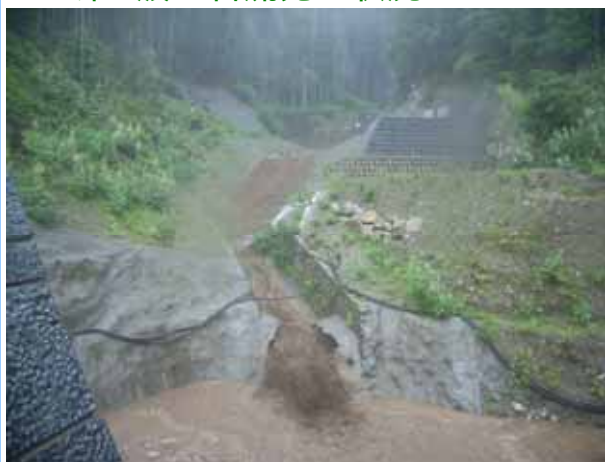
第1波土石流発生状況
