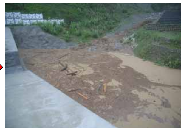
第2波土石流発生状況
