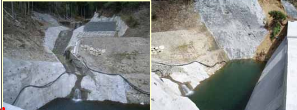
土石流発生前(えん堤上流)
