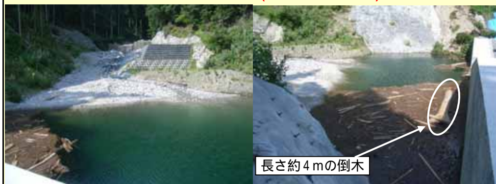
(砂防えん堤で、土砂・流木を捕捉しました)
