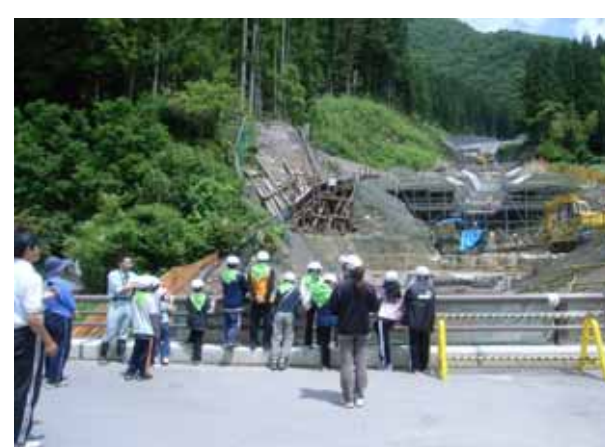
床固工工事現場の見学
