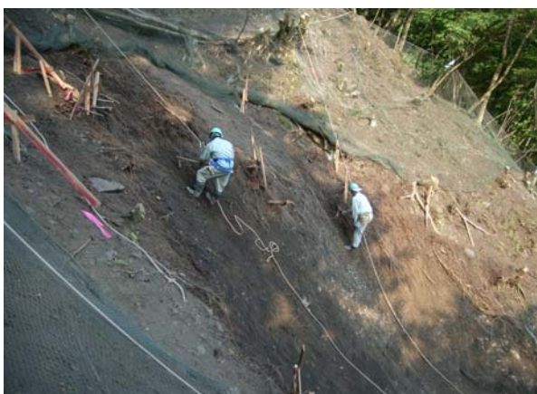
機械の届かないところを人力にて掘削をしています。
