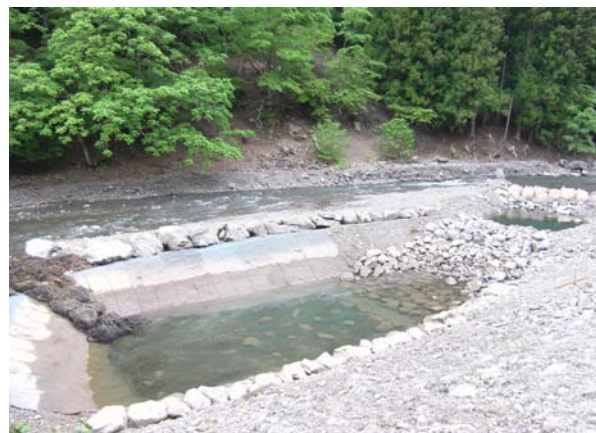
濁り水が少なくなるように下流側の第1堰堤付近へ沈砂地を造成しました。
