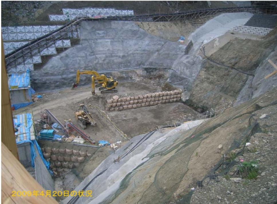
伊ノ木沢砂防堰堤工事は法面工事がもうすぐ完了し、これから主堰堤本体工の施工を行います。
