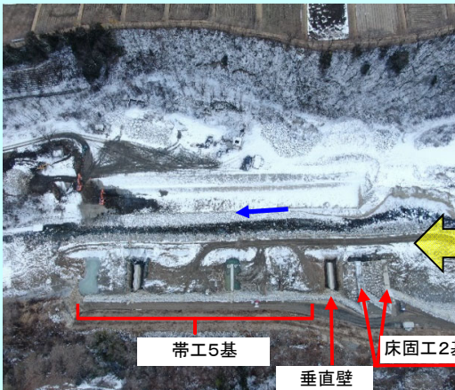
⑤ 令和4年1月末施工状況
