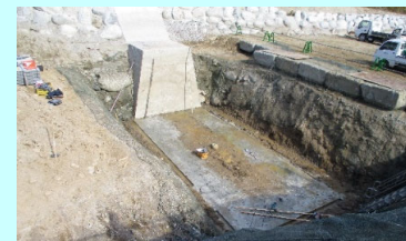
① 令和4年11月 床固工の掘削完了
