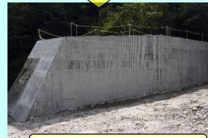
③-2 補強完了 令和4年9月
