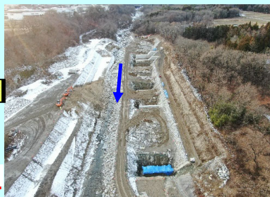
④ 令和4年12月末施工状況
