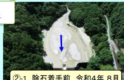
②-1 除石着手前 令和4年8月
