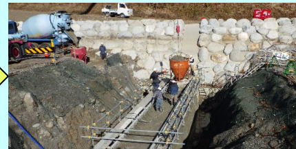
② 令和4年12月 コンクリート打設
