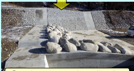
①-2 令和5年1月 床固工施工完了
