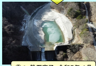
②-2 除石完了 令和5年1月
