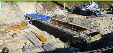
①-1 令和4年11月 床固工施工中
