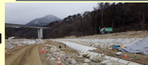
③ 令和5年1月 河床に洗掘防止の根固めブロックを設置
