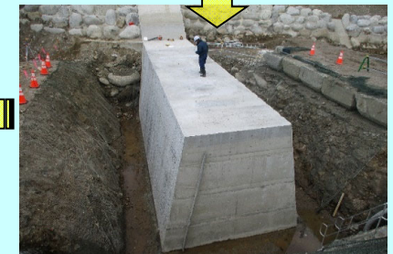
③ 令和4年12月 床固工完成(出来映よし)
