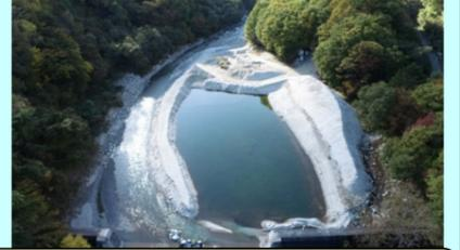
③令和4年 11月現在 飯島第2砂防堰堤 除石(堆砂掘削)施工中
