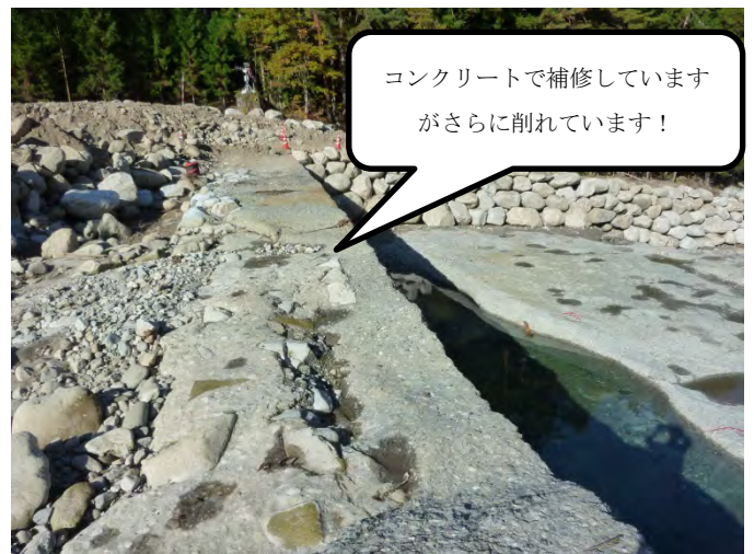
長い役目を終えた砂防施設に代わり、さらに多くの土砂や流木を補足できる「スリット型砂防堰堤」をつくることで、地域の皆さんを土砂災害から守ります！(左図は完成予想図)
