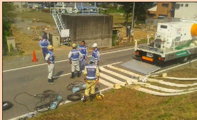
12日小貝川での排水作業を終えた排水車
