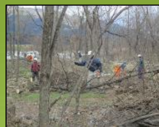
樹木伐採作業
