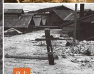
山崩れによる土砂災害（大鹿村）
