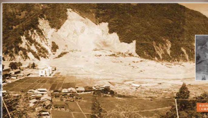
大西山が崩壊し、土砂が土がった瞬間（大鹿村）（中村幸明氏撮影）
