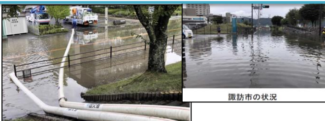
長野県諏訪市での排水作業（天竜川上流の排水ポンプ車 R3.8/15～16）
