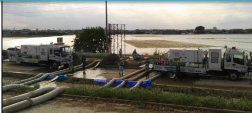
茨城県常総市の浸水箇所での排水作業（天竜川上流の照明車・排水ポンプ車 H27.9/10～18）
