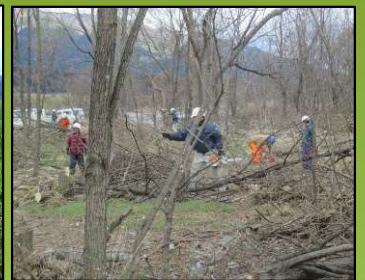
樹木伐採作業
