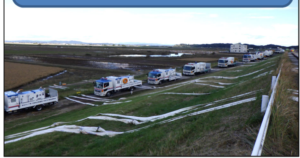
宮城県大崎市の浸水箇所での排水作業 (全国から集まった排水ポンプ車・照明車)
