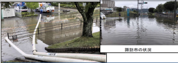
長野県諏訪市での排水作業 (天竜川上流の排水ポンプ車 R3.8/15~16)
