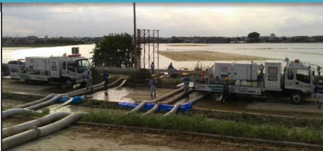
茨城県常総市の浸水箇所での排水作業（天竜川上流の照明車・排水ポンプ車 H27.9/10～18）
