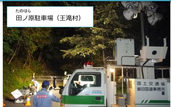
たのはら 田ノ原駐車場（王滝村） 王滝村から要請を受けKu-Sat（本局）と照明車による監視活動への支援（飯田照明車H26.9/29～10/5） 「衛星通信車」による現地映像の配信（天竜川上流の衛星通信車 H26.9/27～28）
