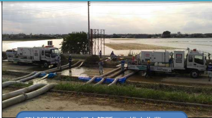
茨城県常総市の浸水箇所での排水作業 (天竜川上流の照明車・排水ポンプ車 H27.9/10~18)
