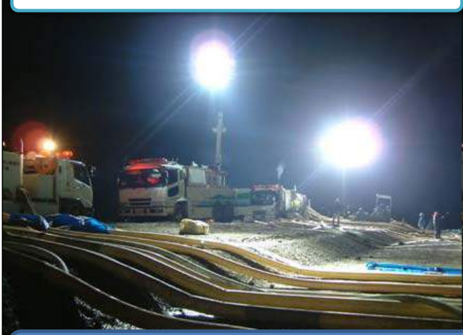
照明車と排水ポンプ車による排水作業 (天竜川上流の照明車・排水ポンプ車H23.3/14~5/9)
