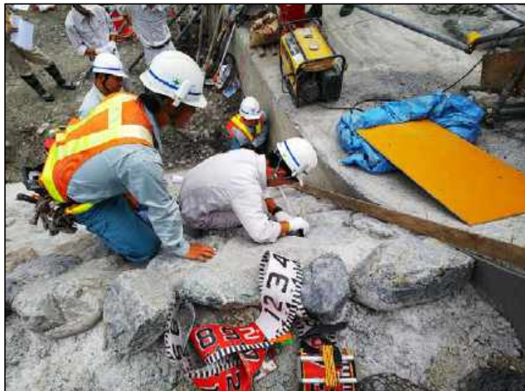
↑砂防工事現場監督実習
