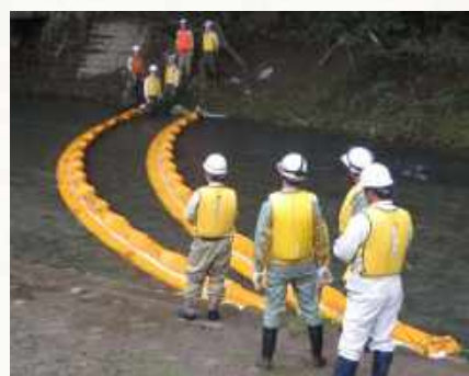
オイルフェンス設置の様子
