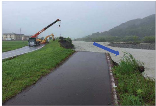
7月1日11:00【復旧工事】 欠損確認後3時間後 ブロック及び土砂の投入
