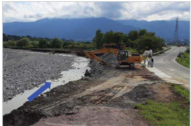
7月2日16:00【復旧工事】 今回出水の高さ相当までの復旧(工事)完了
