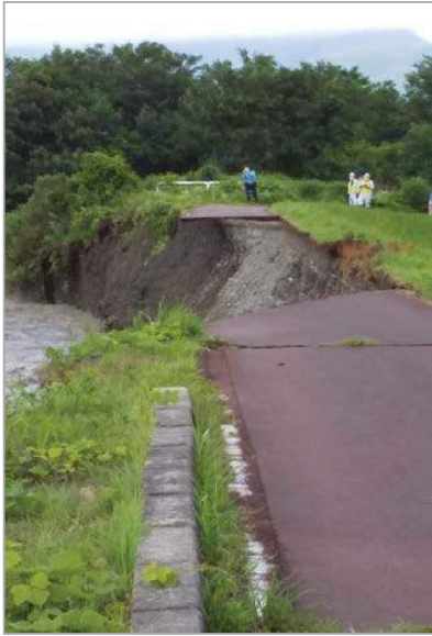
7月1日8:00 堤防の欠損状況の確認
