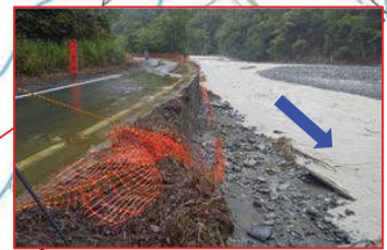
●中川村【小渋川右岸2.9kp】 (河岸洗掘)
