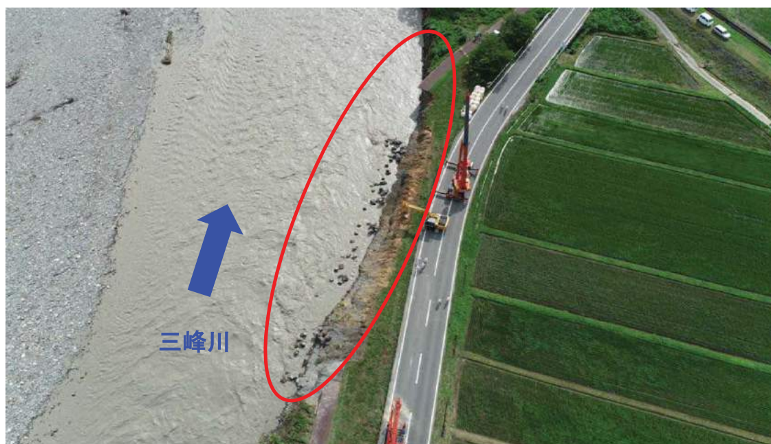
伊那市美篁下県地先(三峰川右岸4.6kp付近)にて約125mにわたり堤防の欠損が発生
