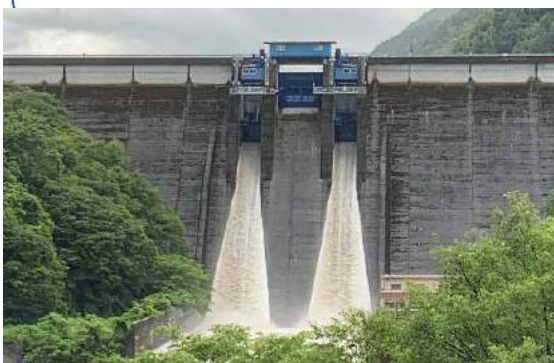
洪水後美和ダム放流状況(7月1日7:20)
