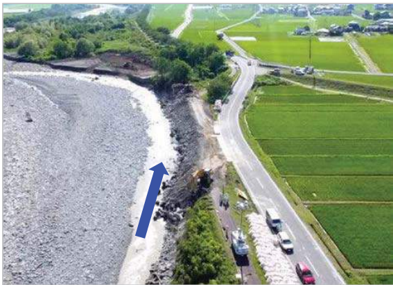
7月2日16:00【復旧工事】 今回出水の高さ相当までの復旧(工事)完了
