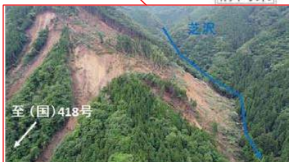
●天龍村足瀬 (土砂崩落)
