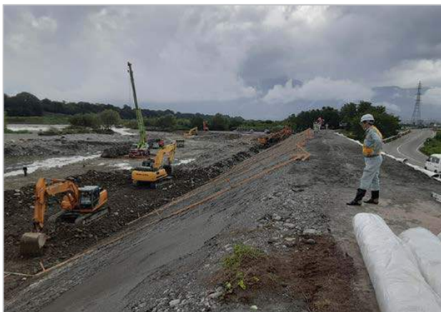
7月7日16:00【復旧工事】 堤防盛土完成
