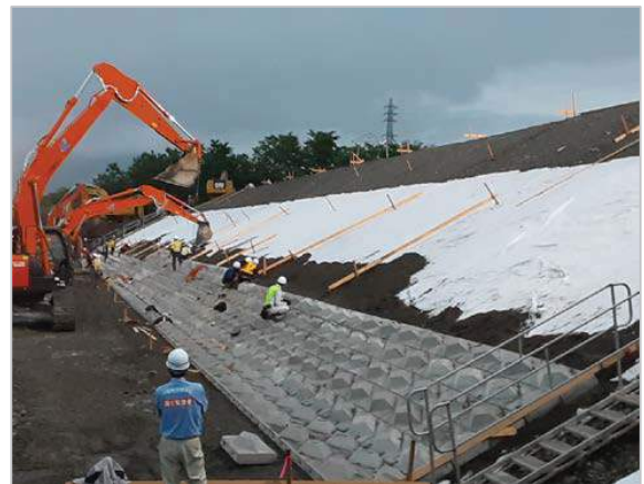
7月9日19:00【復旧工事】 堤防を侵食から守る為の護岸設置状況
