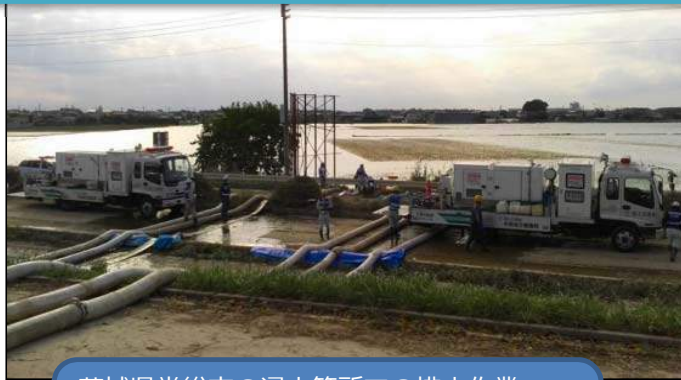
茨城県常総市の浸水箇所での排水作業 (天竜川上流の照明車・排水ポンプ車 H27.9/10~18)
