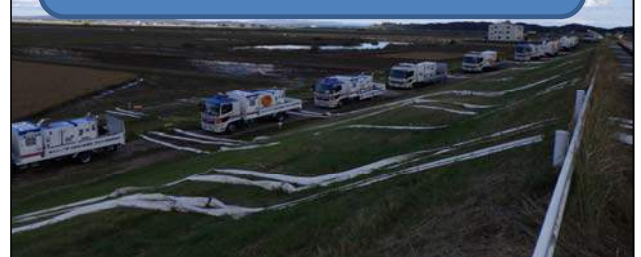
宮城県大崎市の浸水箇所での排水作業 (全国から集まった排水ポンプ車・照明車 R1.10/16~23)
