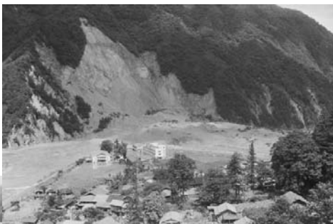
崩落した大西山付近の様子 (大鹿村)
