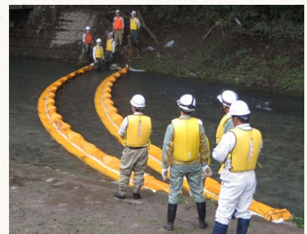
オイルフェンス設置の様子
