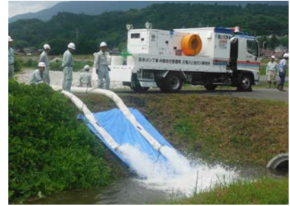
ポンプ排水状況
