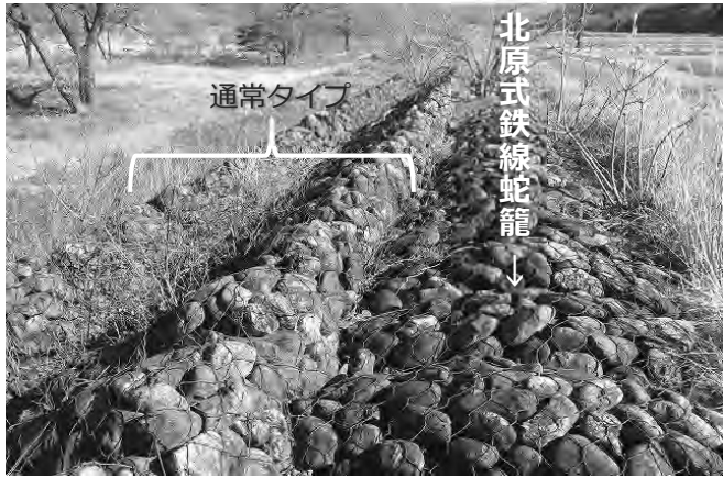
写真 23 : 北原式鉄線蛇籠 (榛原河川公園)
