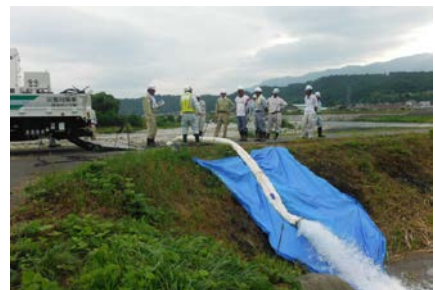
ポンプ排水状況
