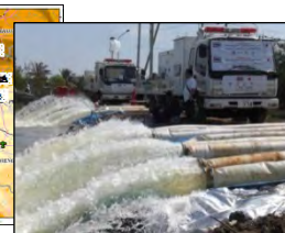
【工業団地での排水作業】
