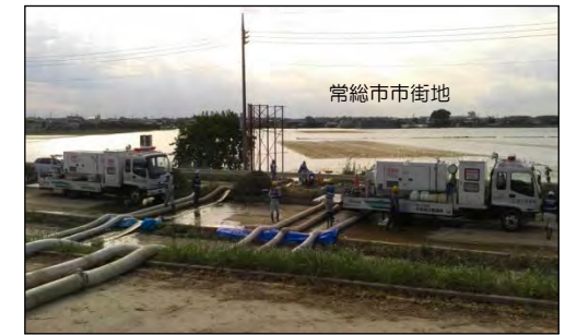
【排水作業にあたる排水ポンプ車】
