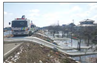
【ポンプ車による排水作業】
