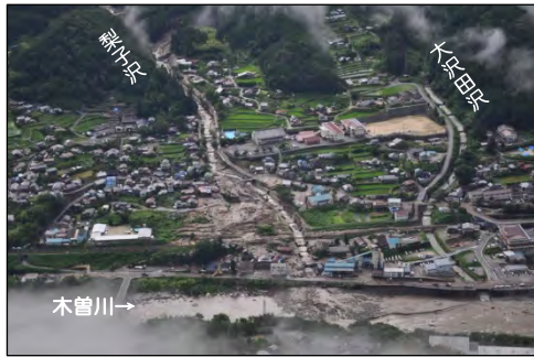
【上空から見た被災状況】
