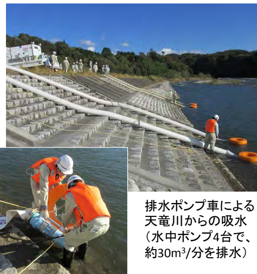
水中ポンプの投入
