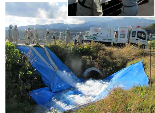
排水状況(法面をシートで保護)
