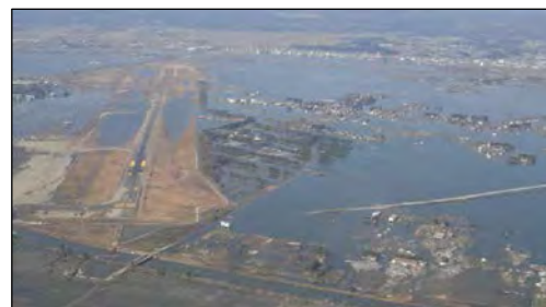
【被災した仙台空港】
