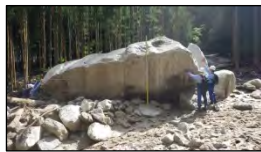
【被災状況調査】
