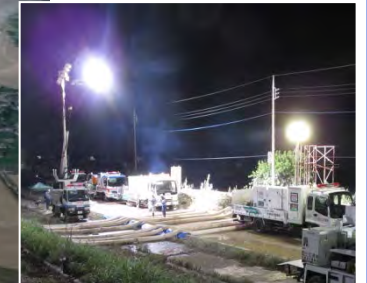
【夜間の排水作業】
