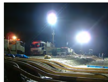
【照明車とセットで夜間の排水作業】
