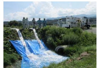
ポンプ排水状況
