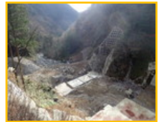
建設中の黒川第4砂防堰堤
