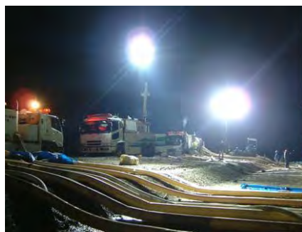
東日本大震災に出動し支援活動を実施(照明車及び排水ポンプ車による排水活動)
