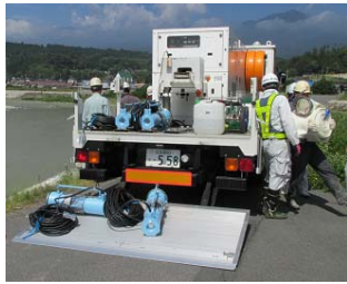
排水ポンプ等の降ろし
