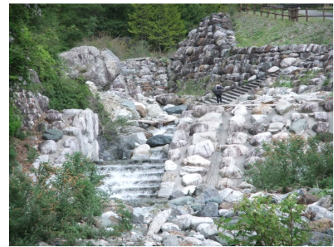
大島河原床固工
