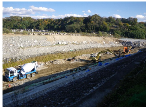
天竜川飯田地区堤防補強工事
