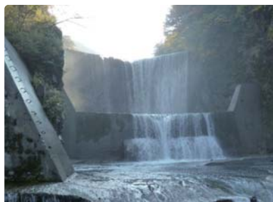
例) 上蔵砂防堰堤 (わざさほうえんてい)
