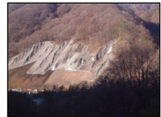
鹿塩川山腹工
