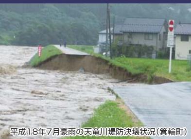
平成18年7月豪雨の天竜川堤防決壊状況(箕輪町)
