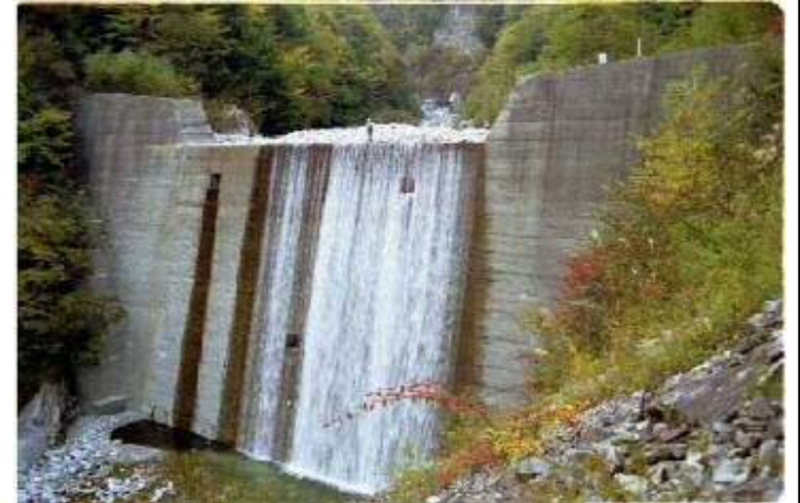
Ka-04 松川第3砂防ダム H11.10
