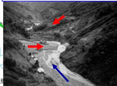
鹿塩川を一時せき止めた西山地区の崩壊と土砂流出(S36.6)
