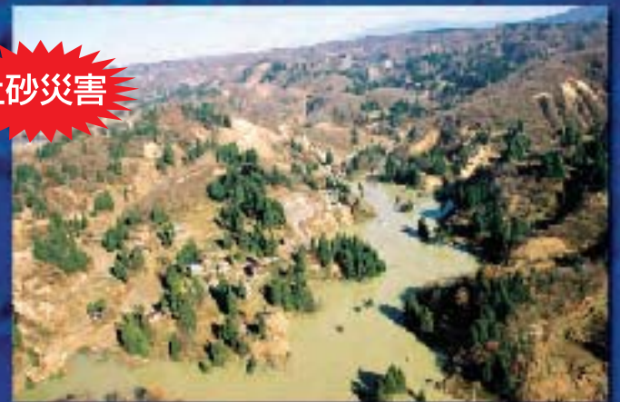
新潟県中越地震による土砂ダム(2004)
