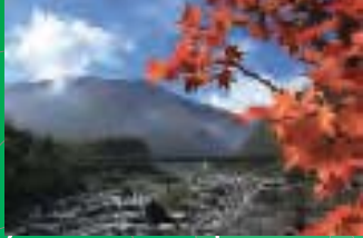
太田切川床固工群
